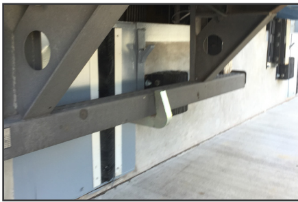
El retenedor PowerHook busca, encuentra y asegura la RIG del remolque al muelle/andén.
